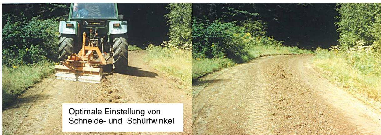
**Abb. 8 Hereinholen von Verschleißschichtmaterial 2. Durchgang pro Seite**
