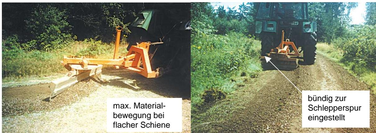
**Abb. 6 und 7 Entfernen von Graswuchs, Hereinholen von Verschleißschichtmaterial in die Fahrbahnmitte; i. d. R. 2 Überfahrten pro Seite**
