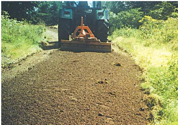
Abb. 10 Verteilen des Verschleißmaterials aus der Fahrbahnmitte in die Fahrspuren mit der Stahlschiene in geänderter Einstellung
