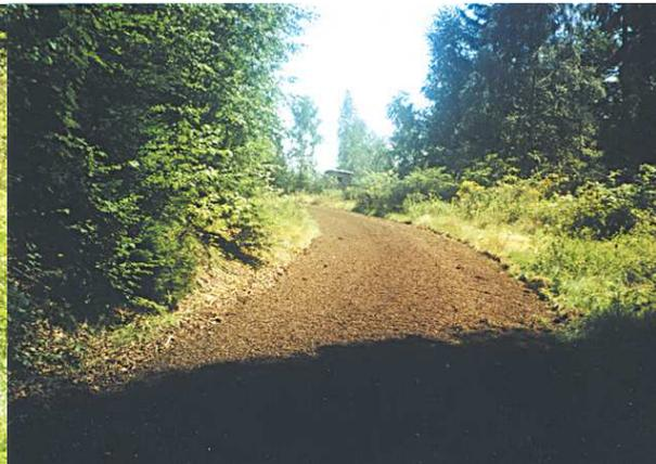
Abb. 11 Wiederhergestelltes Dachprofil eines turnusgemäß gepflegten Waldweges. Ein überzeugendes Ergebnis
